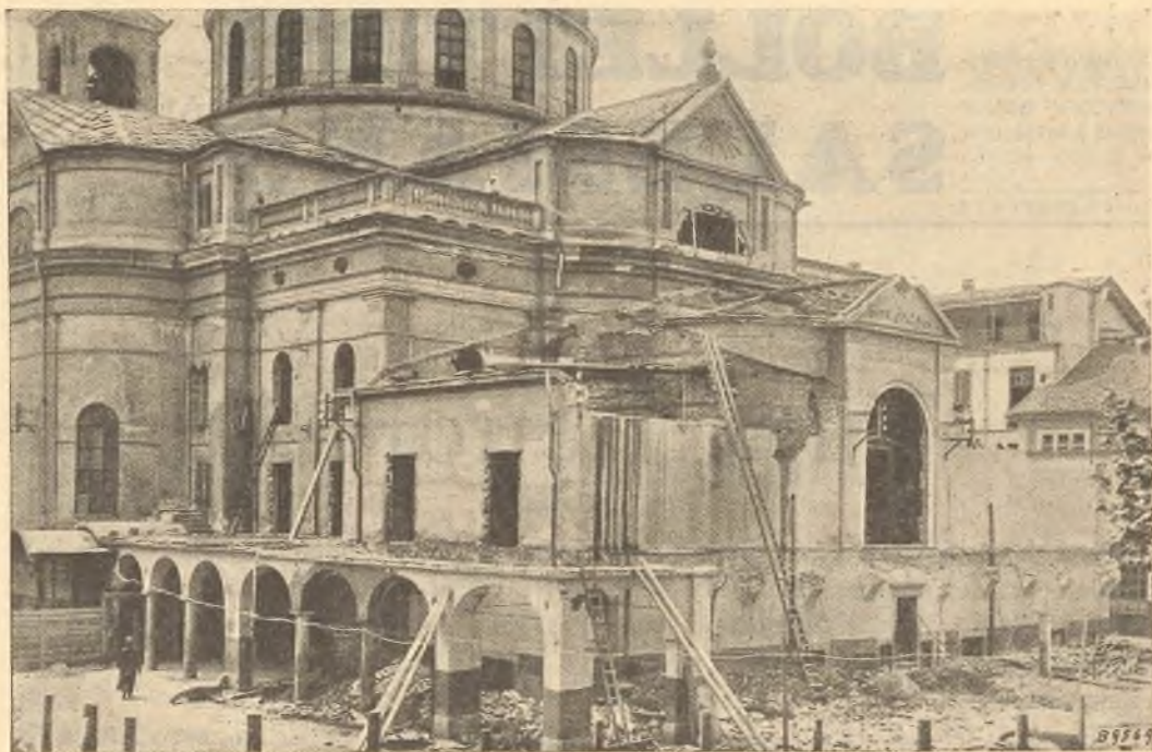
L'abside del Santuario di M. Ausiliatrice all'inizio dei lavori di demolizione in preparazione all'ampliamento progettato.
